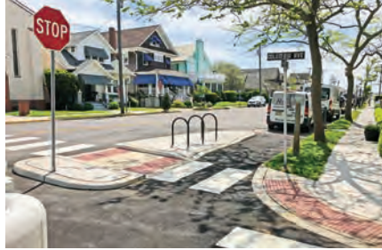
Reducción o dieta de la calle, extensión de la acera, rampas y más
